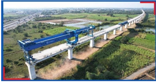
高速鉄道建設工事の様子
